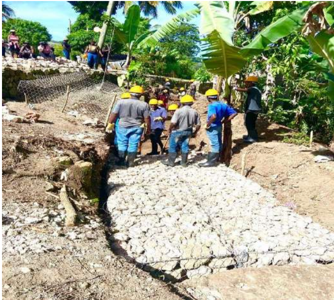
Travaux de gabionnage à la Source située à Bassin Bleu dans le département du Nord- ouest dans le cadre du HA-J0005
