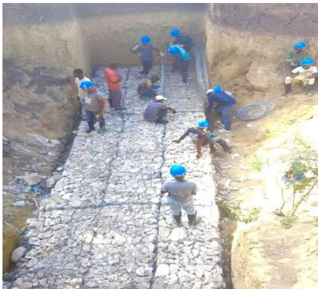
Travaux de gabionnage à la Source située à Bassin Bleu dans le département du Nord- ouest dans le cadre du HA-J0005
