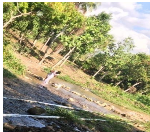
Zone de construction du ponceau
