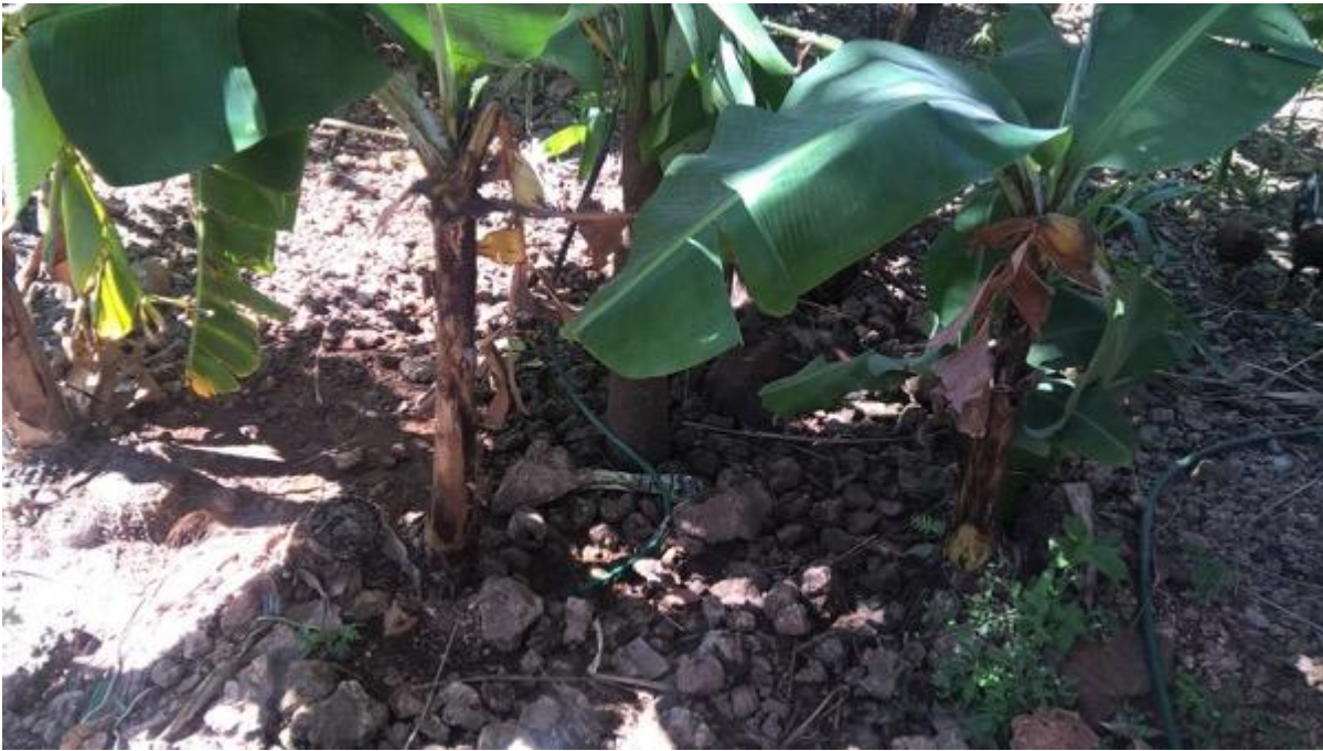
Fig8. Vue d'un branchement privé du réseau de Rodolphe
