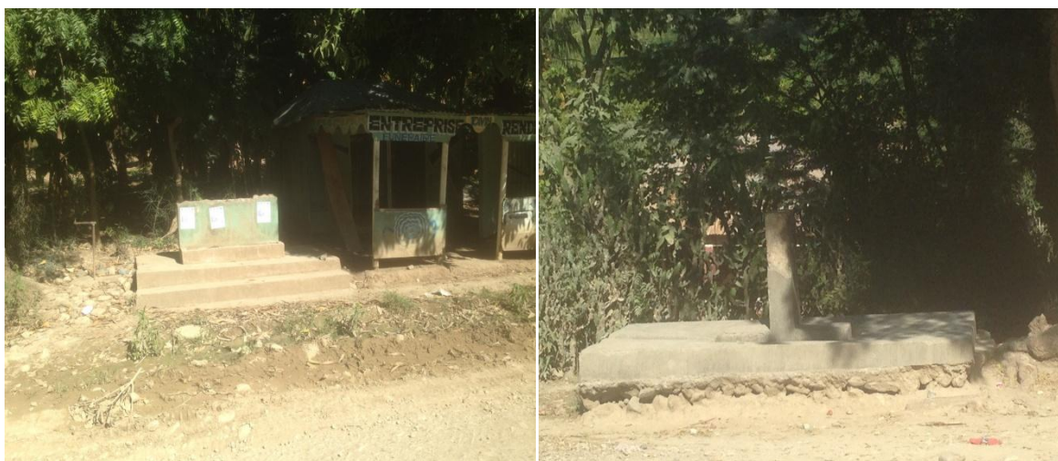
Fontaines publiques hors service
