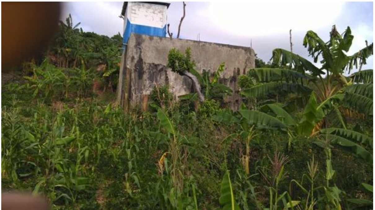
Fig5. Position du réservoir de Mapou.
