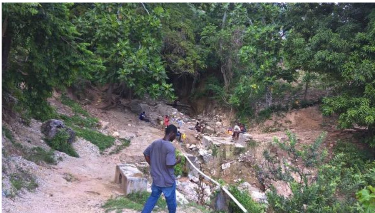
Fig8. Tuyaux traversant une petite ravine.
