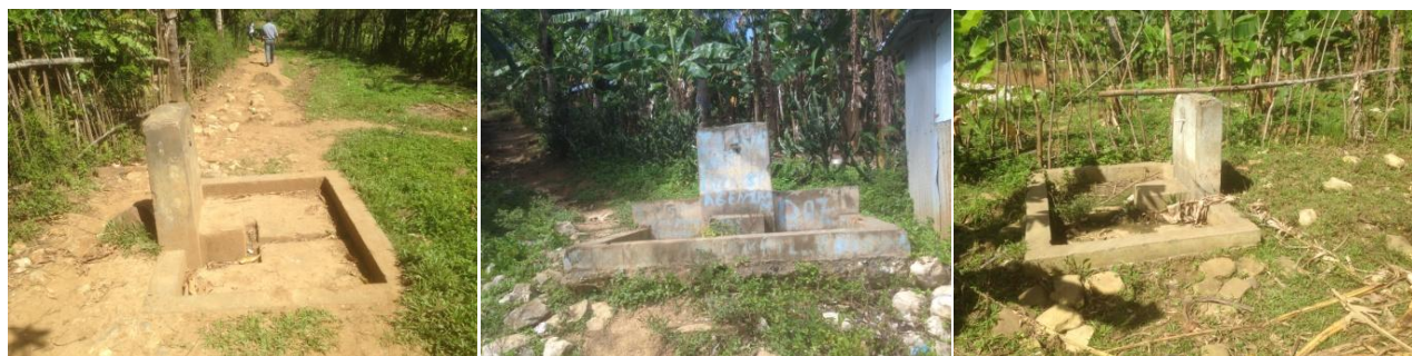
Quelques fontaines à Guichard hors service et ensablées
