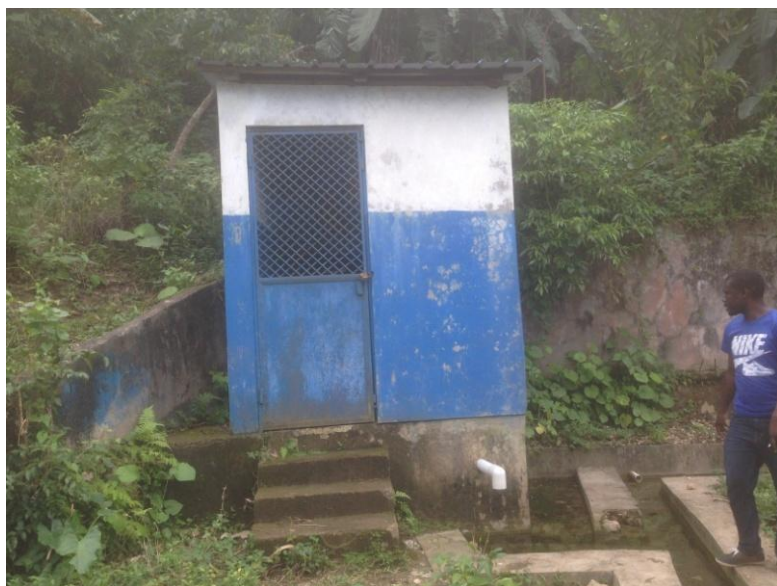
captage source Dubois et chambre de chloration
