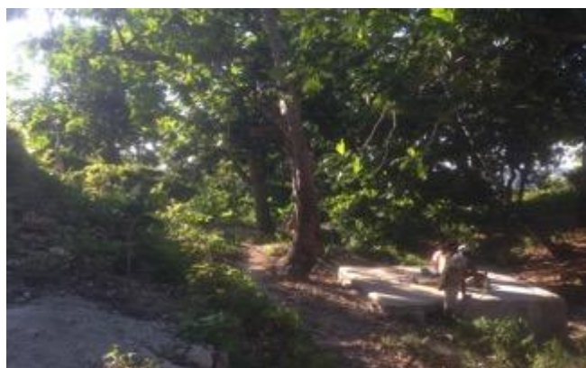
Captage et bassin collecteur
