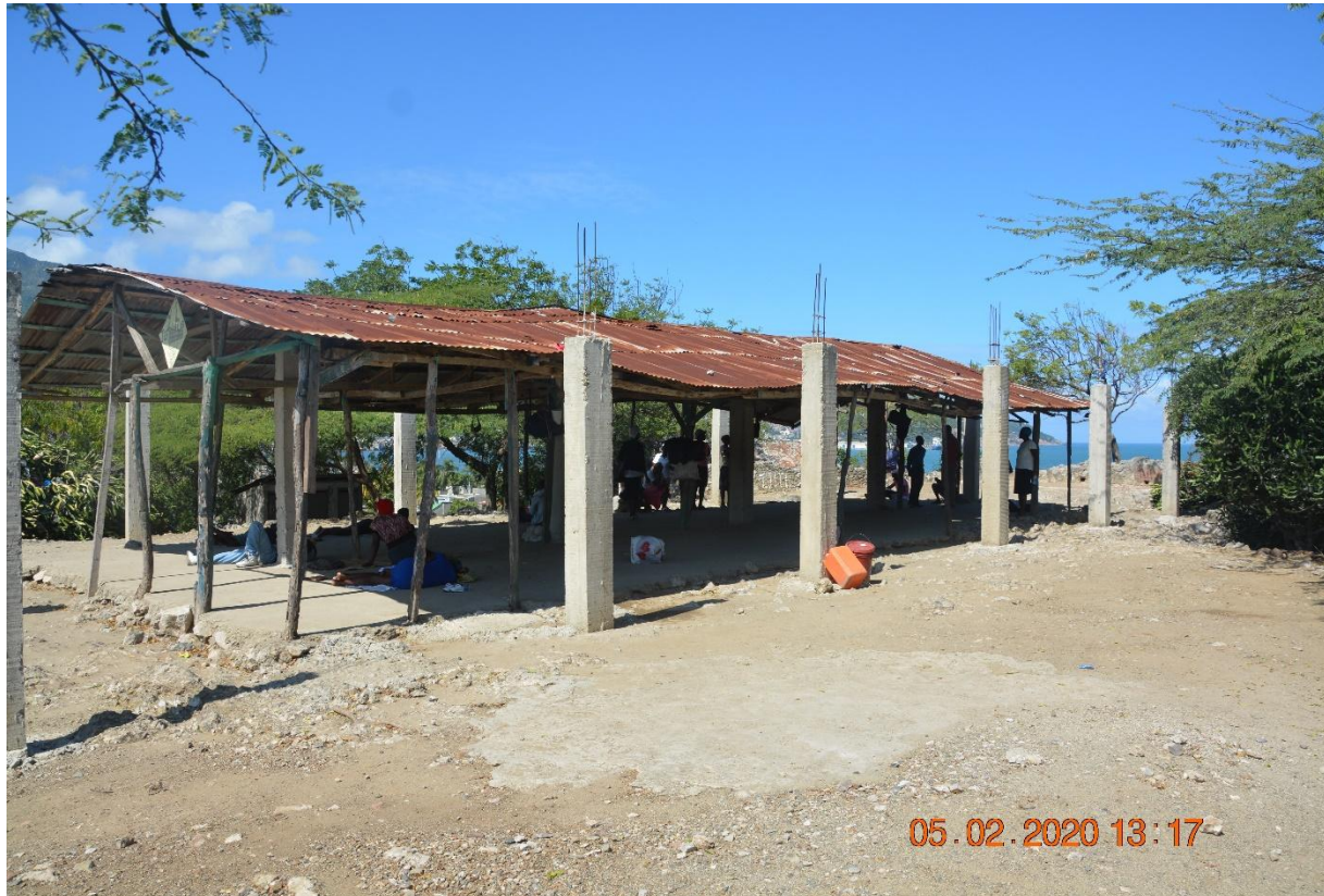
Image 6- Photographies du site de Fort Saint-Michel (ISPAN, 2020)
