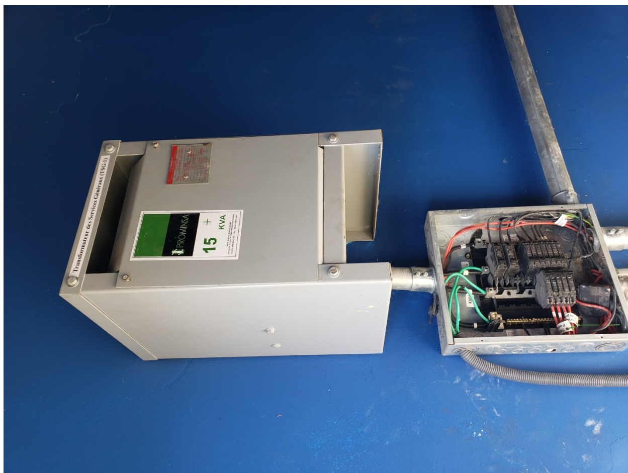
Couloir de contrôle
