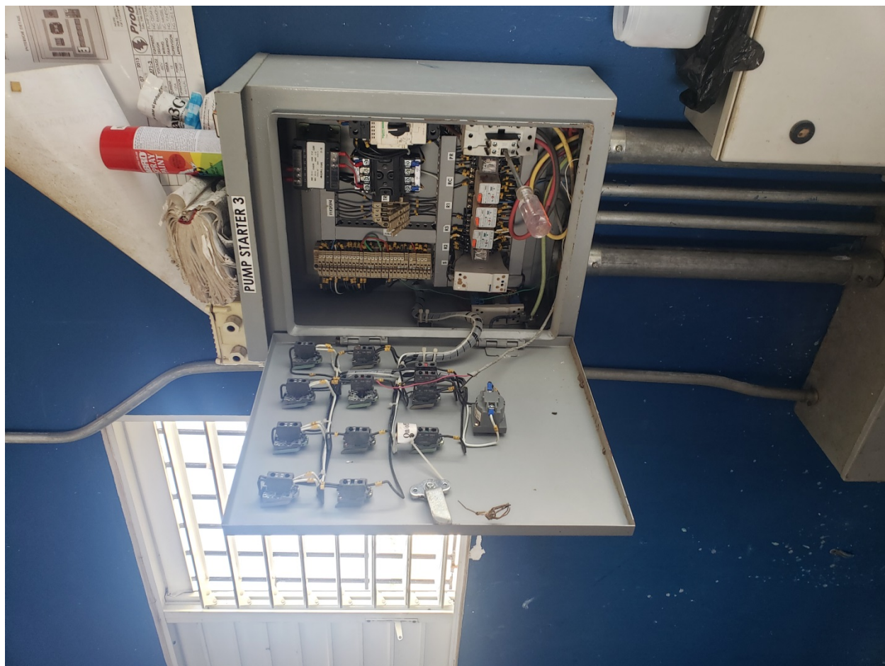
Coffrets de commande des pompes I et III
