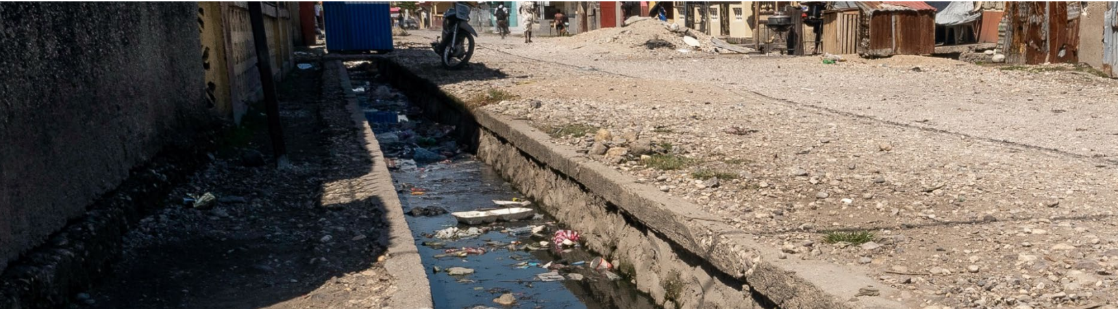
Figure 2- Les Cayes près du réservoir de la Savanne
