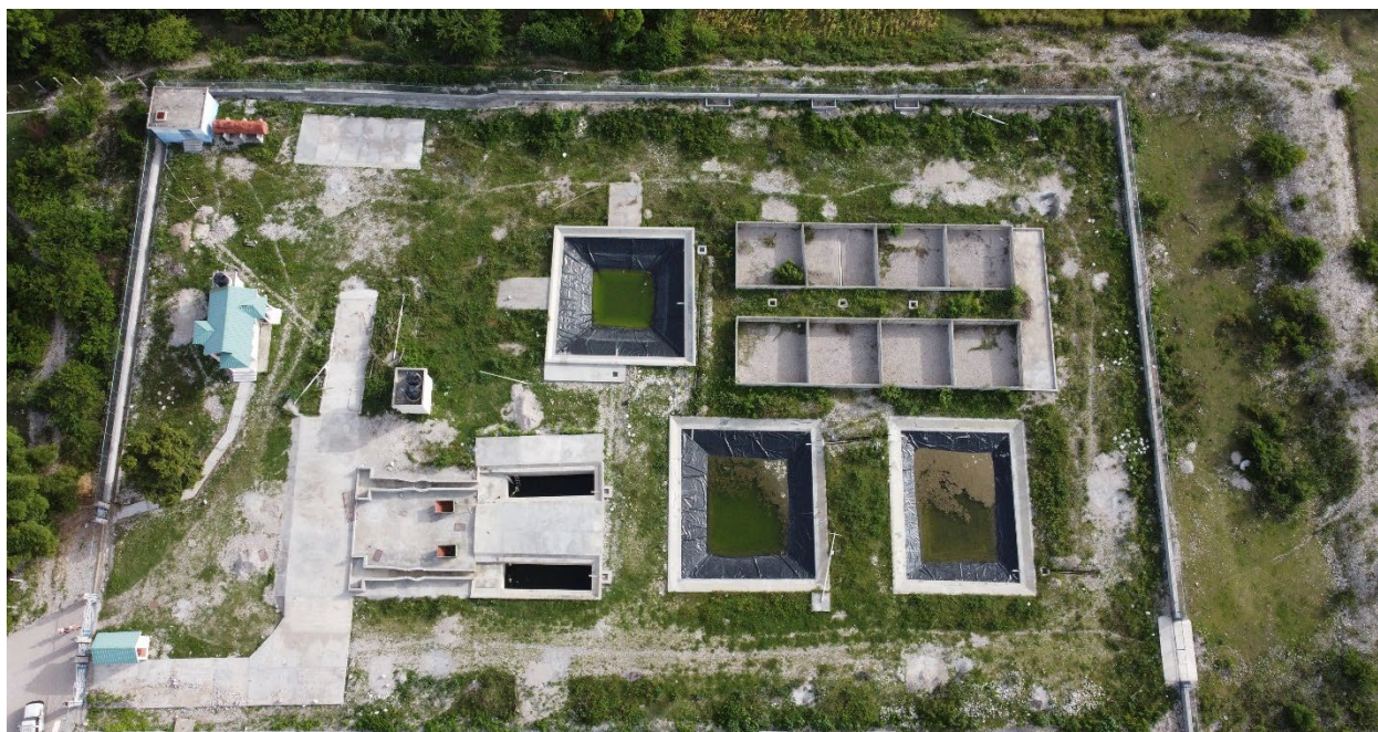
Figure 8- Vue aérienne du site de gestion des boues fécales de Fonfred. Les étangs anaérobies sont les longues structures rectangulaires dans le coin inférieur gauche. Les étangs de maturation sont les trois structures carrées. Les coussinets de séchage sont les petits carrés en haut à droite.
