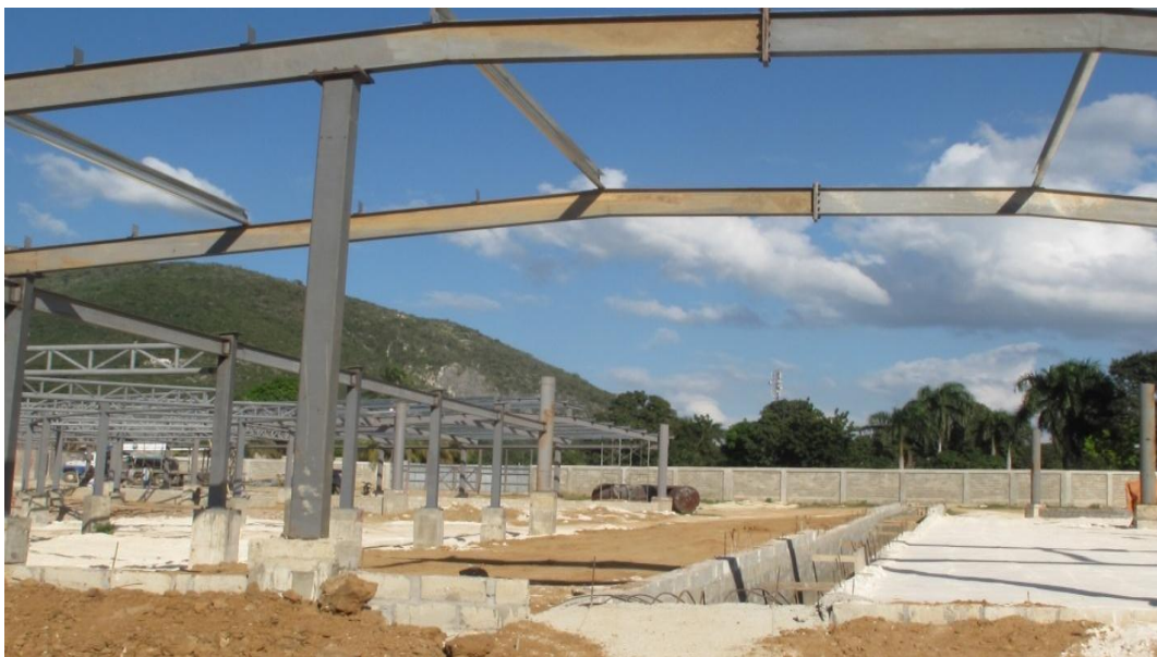
Le Marché public de Pignon en construction
