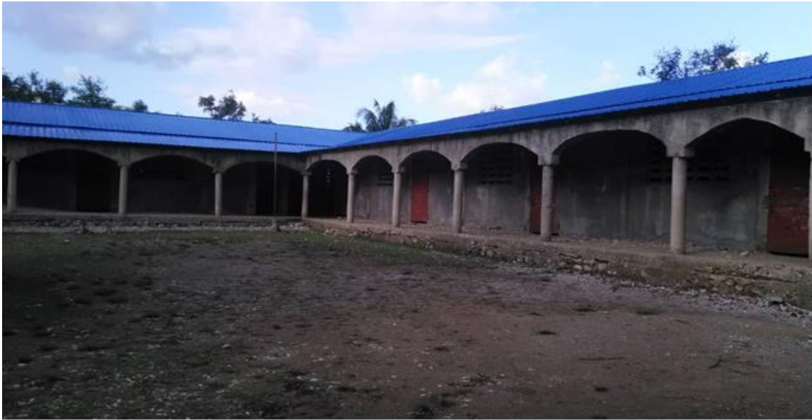
Construction de l'École Nationale de Caïman à Chantal - Photo#2
