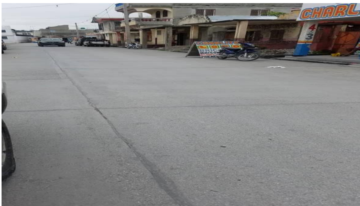
Rénovation urbaine des Cayes - Rue Général Marion
