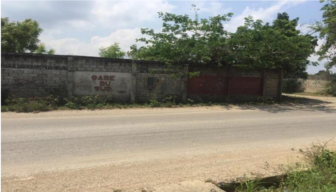
Construction de la Gare Routière Sud à Gressier – photo #2
