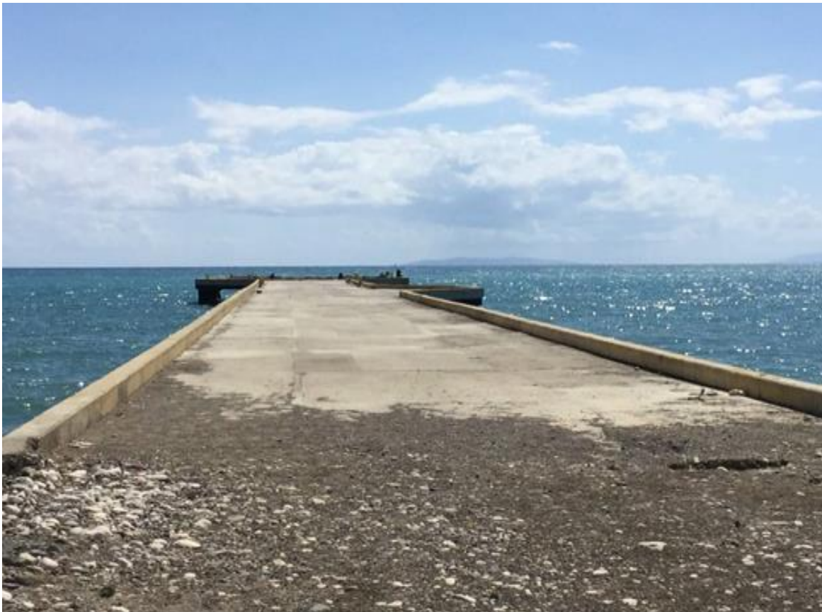
Vue de la réhabilitation du Wharf de Jérémie (photo #1)
