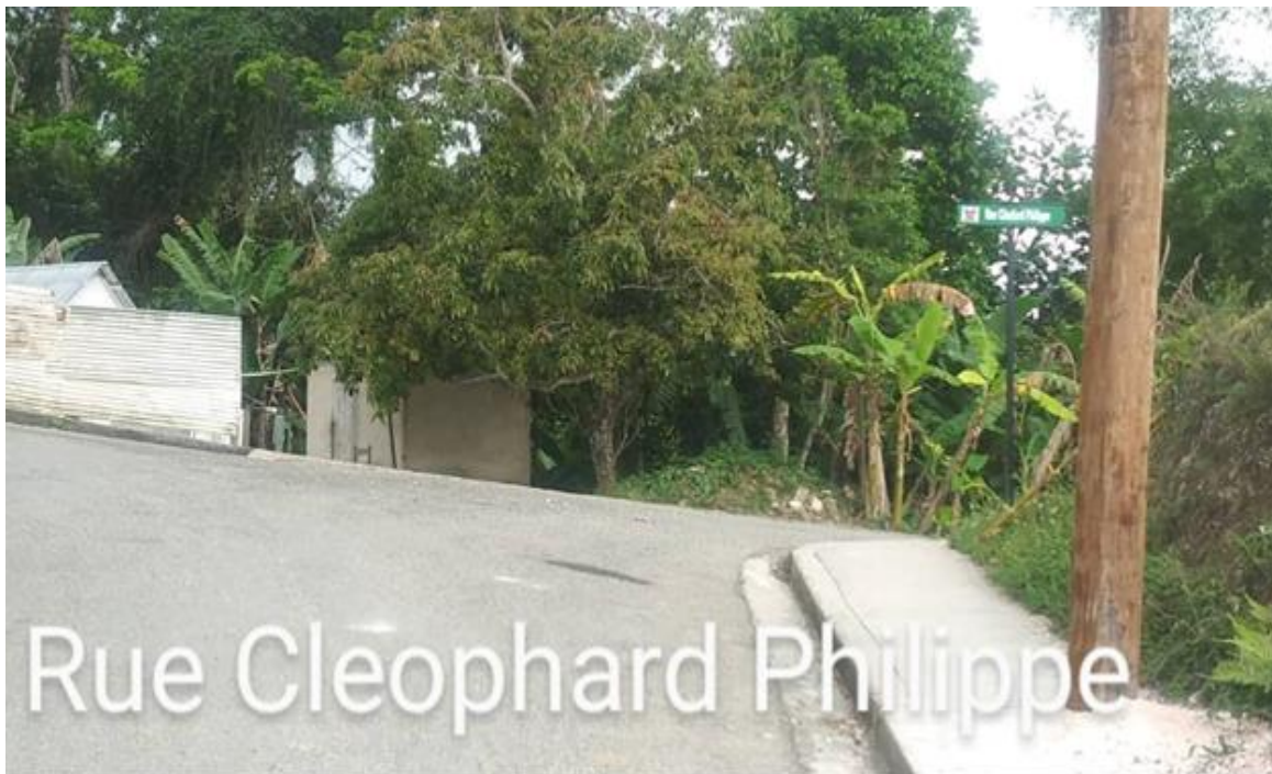
Travaux d'asphaltage de la Vallée de Jacmel – photo de la «Rue Cléophard Philippe»
