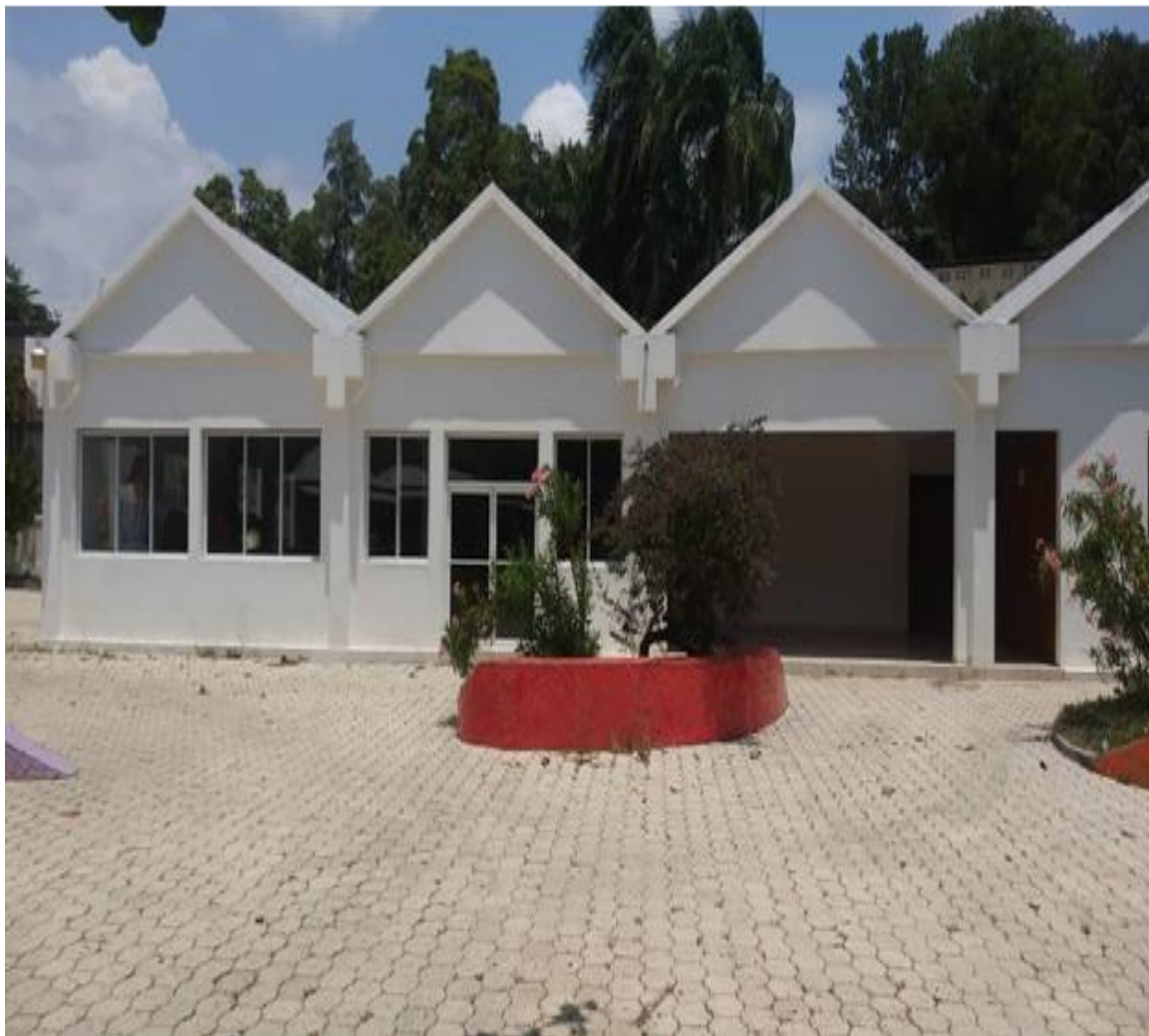
Travaux de construction du Centre d'Interprétation du Carnaval de Jacmel – photo # 1
