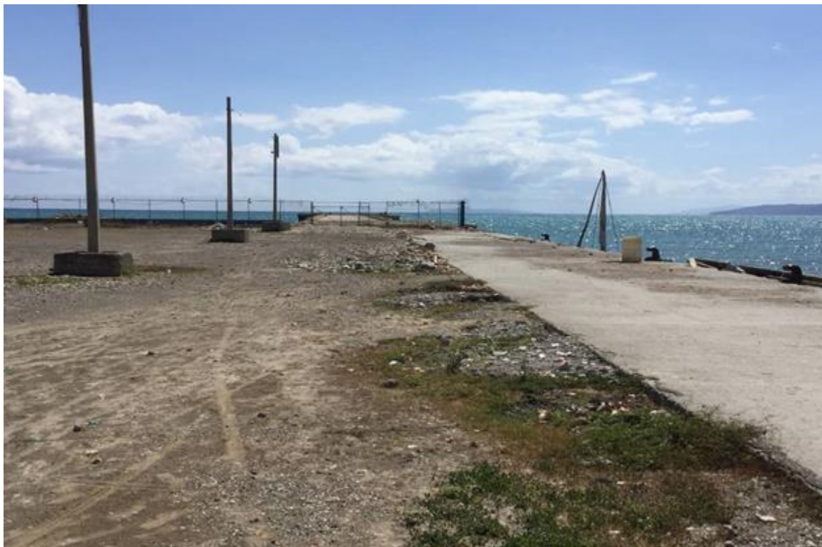
Vue de la réhabilitation du Wharf de Jérémie (photo #2)
