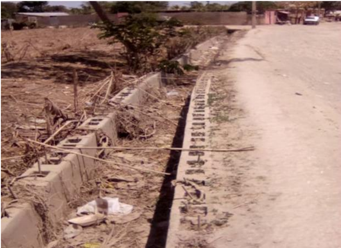
Réhabilitation de la Rue Guerrier à Saint Michel de l'Attalaye Photo d'un Caniveau (Rue Guerrier)
