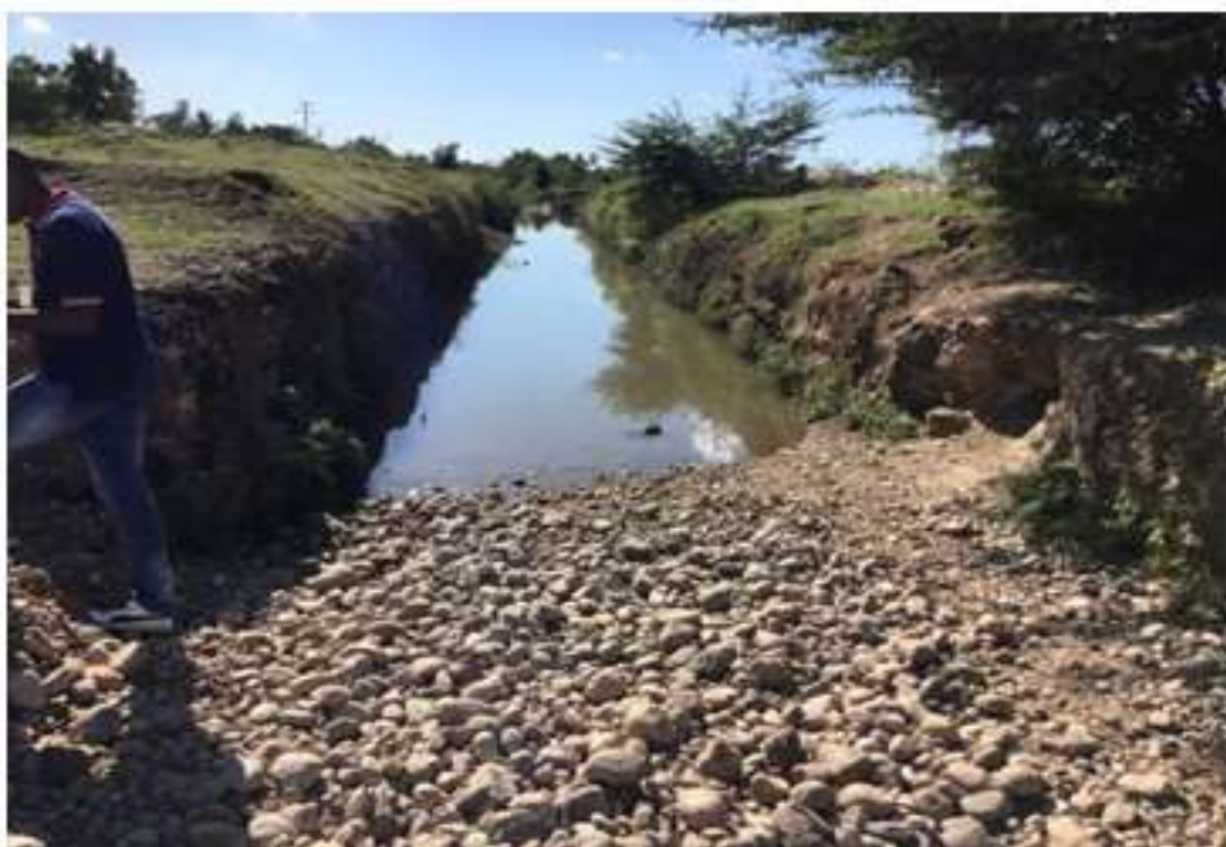
Photos 3 et 4 : Entraves ruisseau et cours d'eau
