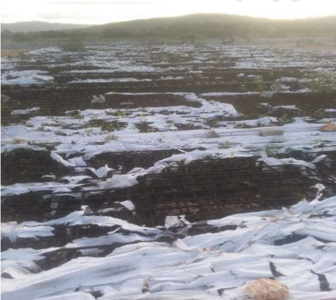
Socle pour l'installation du marché inachevé
