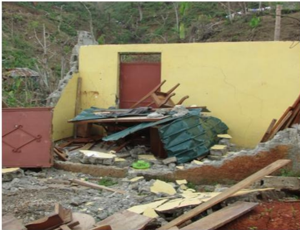
espace administrative et de stockage de CATEPS
