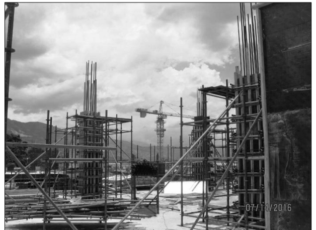
Vues d'une sélection d'engins lourds mobilisés. Coffrages de colonnes de rez de chaussée.
