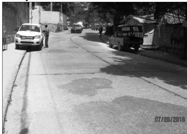
Réparations du revêtement en béton
