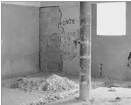
Phase 3, Lot 1: gros œuvre du bloc opératoire
