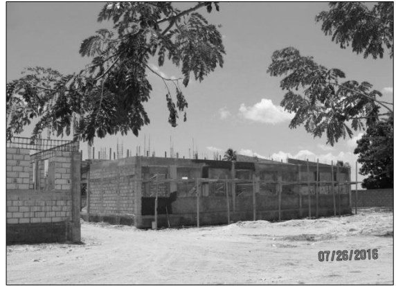
Vues extérieures des travaux de gros œuvre
