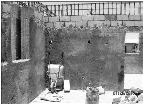
Travaux de cimentage de maçonnerie hors séquence d'une progression planifiée des travaux
