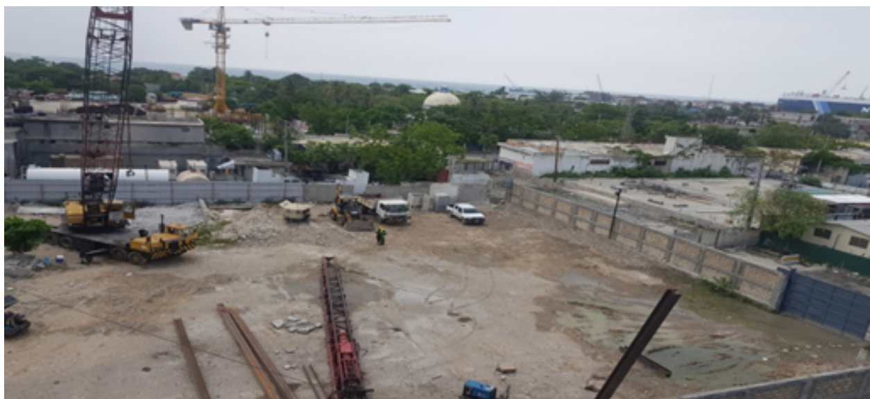
Vue 5 : Vue aérienne du site de construction du Musée de la Monnaie
