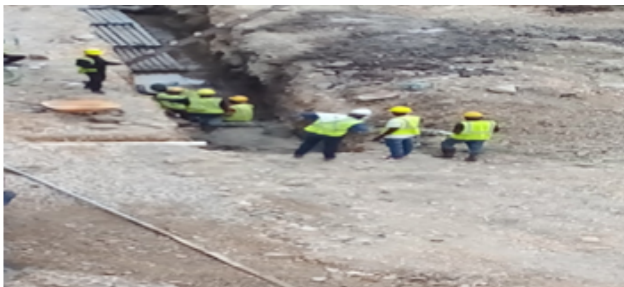
Vue 4 : Vue aérienne des travaux de construction d'un réseau souterrain de raccordement de la centrale électrique avec les autres bâtiments de la BRH
