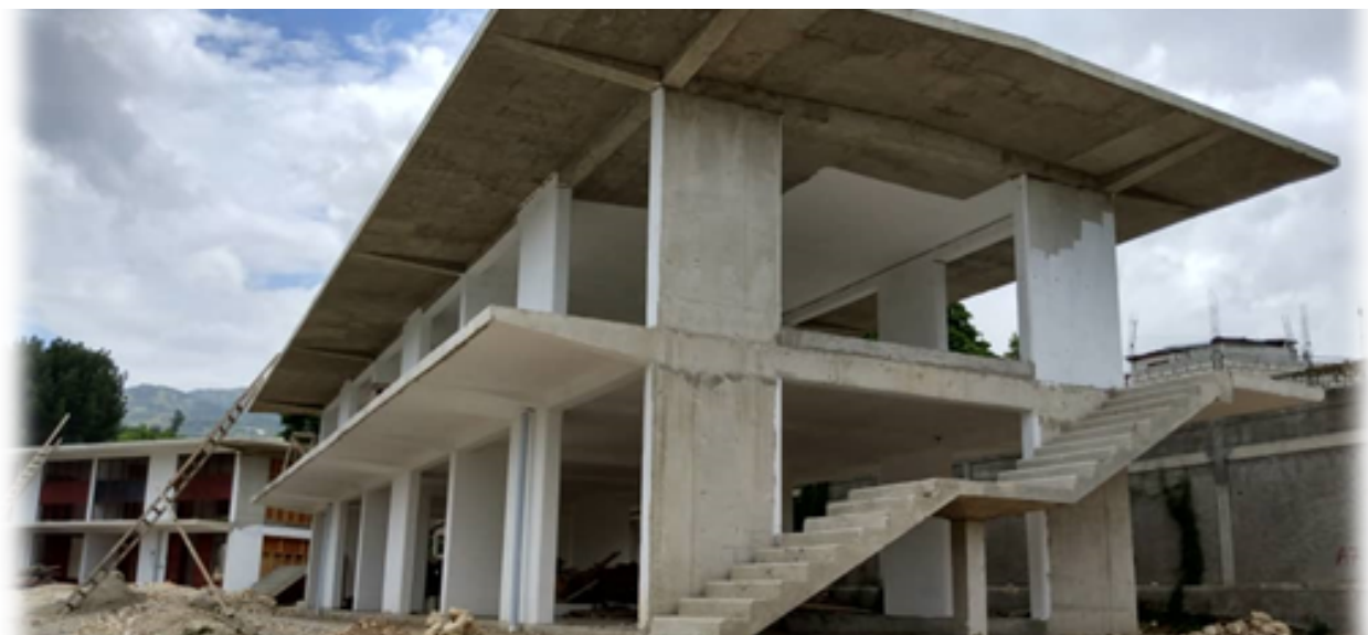
Vue 2 : Chantier de la construction du Lycée national de Frères
