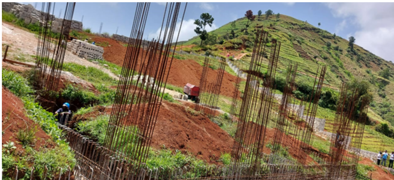
Vue 3 : Site de construction de l'École Nationale Union Communautaire de Berthé
