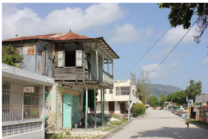
centre ville de Grand-Goâve, maison ancienne
