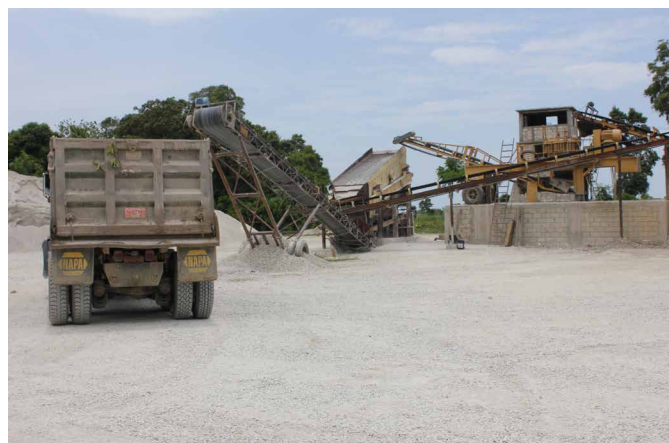
Entreprise de gravier et sable, Léogâne
