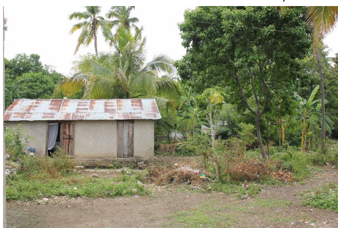
zone d'extension au Sud de la RN2
