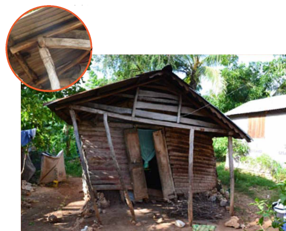
maison en bois résistant aux secousses sismiques
