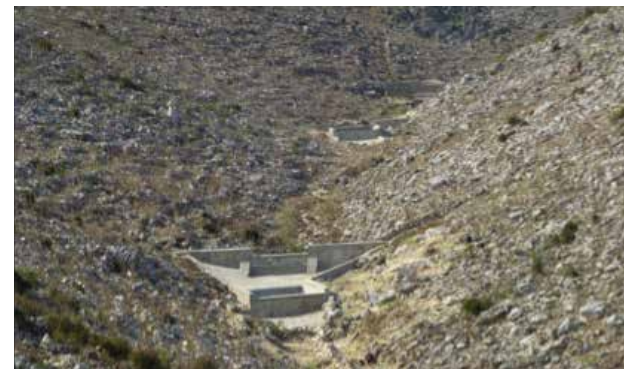
Seuils et bassins dans la ravine Fonds dégâts (Chaîne des Matheux)
