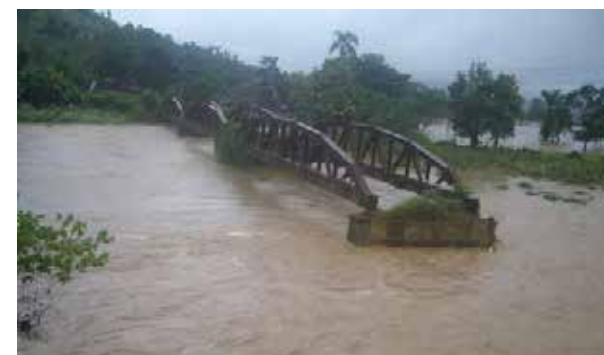
Inondation « fluviale » en lit mineur et majeur (ancien pont de Limbé, dans le Nord d'Haïti)
