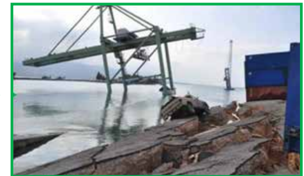
Glissement des berges dus à la perte de résistance du sous sol lors de la vibration sismique
