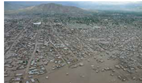
Inondations aux Gonaïves lors du cyclone Jeanne, 2004
