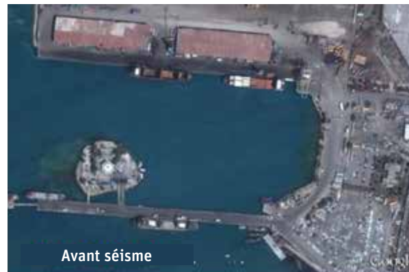
Zone portuaire de Port-au-Prince – exemple des désordres provoqués par la liquéfaction des sols suite au séisme du 12/01/2010
