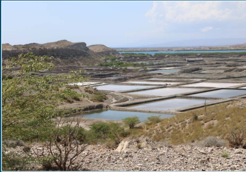
Une gestion moderne avec réservoir, condensateur et cristalliseur
