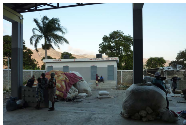
Un des 4 blocs sanitaires du marché.
