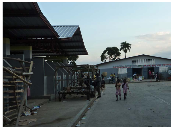
Espace quincaillerie (à gauche), allée et magasins dépôts (au fond)
