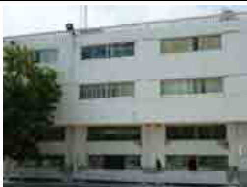
Fig. 2-9 Structure en portiques avec remplissage en maçonnerie
