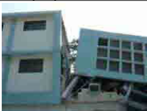
Fig. 8-3 La bonne tenue de la partie de 2004 peut s'expliquer par la présence des murs
