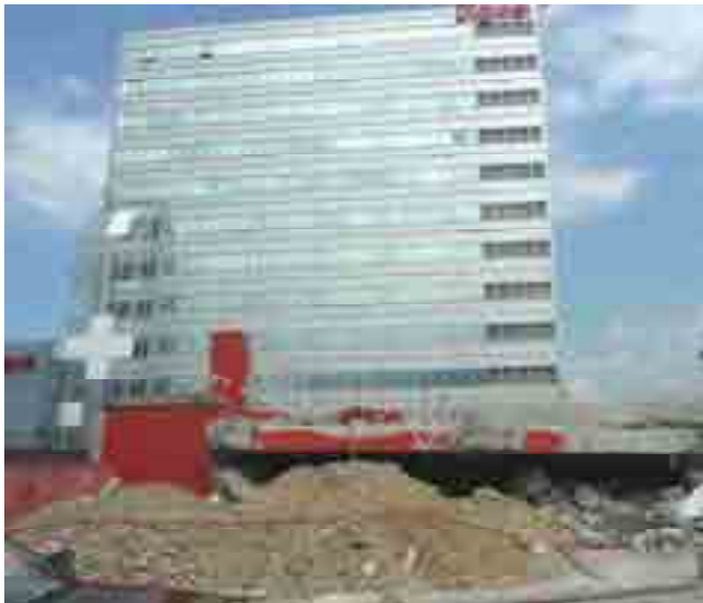
Fig. 11-1 Bâtiment DIGICEL en fonctionnement aucune vitre cassée
