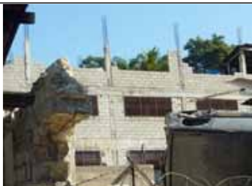
Fig. 1-1 Doubts sur le type de structure : murs en maçonnerie porteuse ou portiques BA
