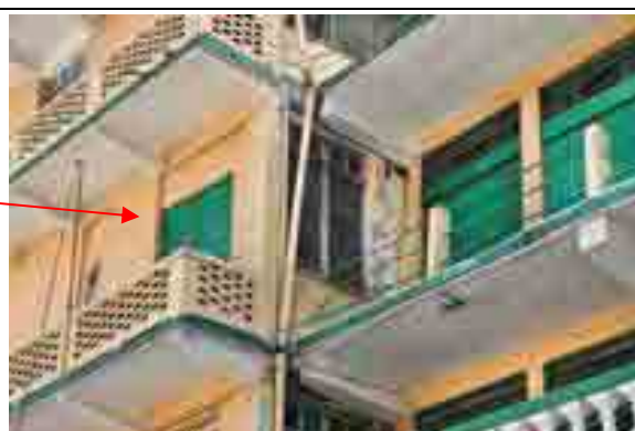
Fig. 7-10 Le joint de dilatation
