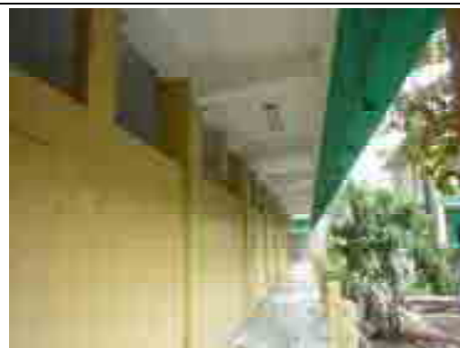
Fig. 7-12 Poteaux courts façade arrière
