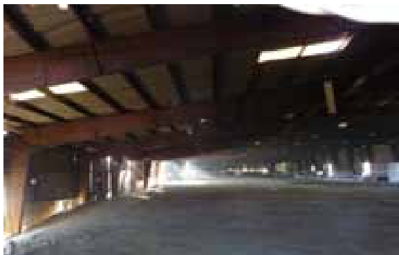
Fig. 15-5 Hall de 50 m de portée et d'une longueur de 200 m
