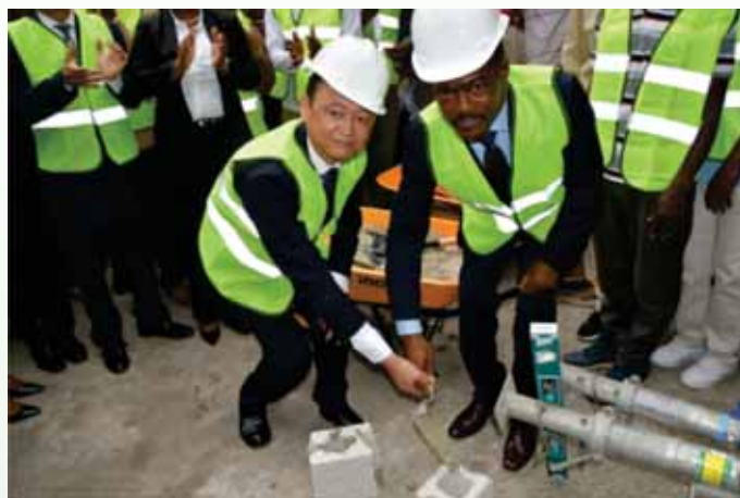
L'Ambassadeur du Japon et le DG du BMPAD lançant les travaux de réhabilitation et de renforcement de la Faculté des Sciences Humaines
