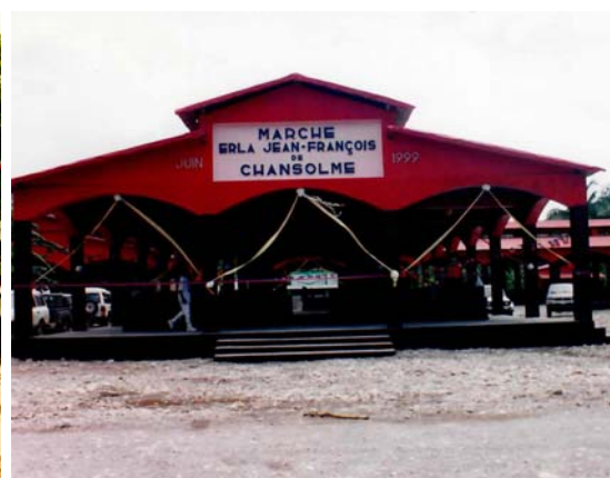
Construction du marché de Chansolme
