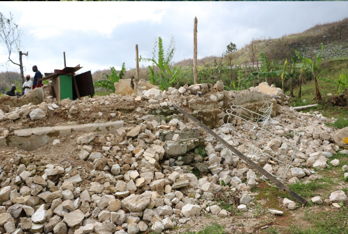
Maison complètement détruite à Formon
